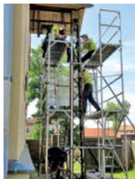
Bei der Restaurierung in Zerpenschleuse, Brandenburg
