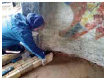
Der Boden wird gepflastert
