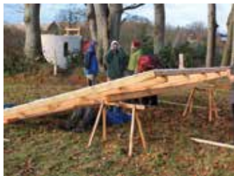
Arbeiten am Notdach
